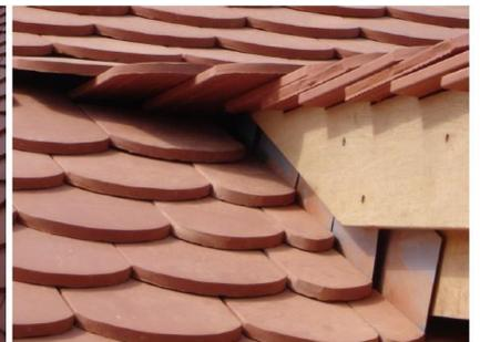
Übergang Hauptdach Gaube mit Blechnoggen herausgedeckter Übergang
