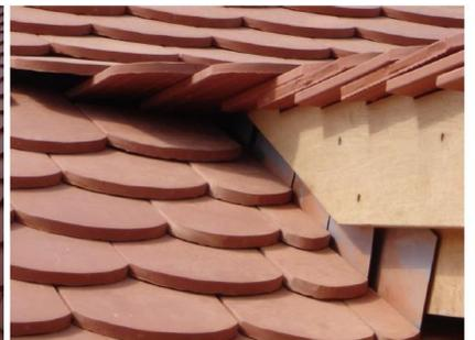
Übergang Hauptdach Gaube mit Blechnagel herausgedeckter Übergang
